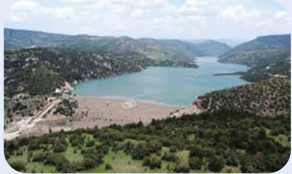
Görsel 3.13: Eğrekkaya Barajı
