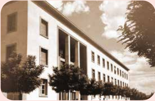
Görsel 5. 62: Ankara Eski Radyo Televizyon Binası
