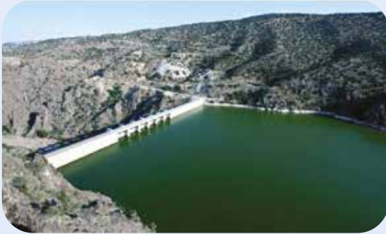
Görsel 3.12: Sarıyar Barajı
